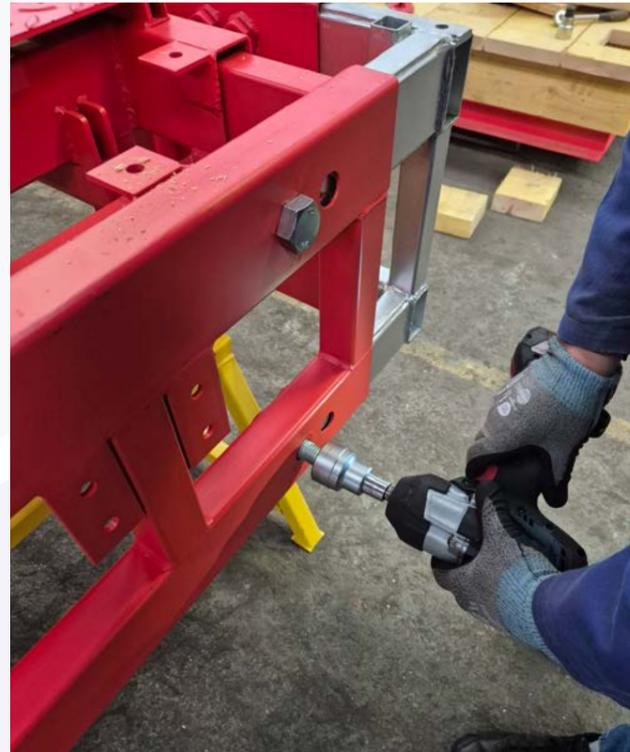
➤ Verrouiller avec vis HM24 (4 par faces). Utiliser une clé avec douille de 36 ou clé de banche
